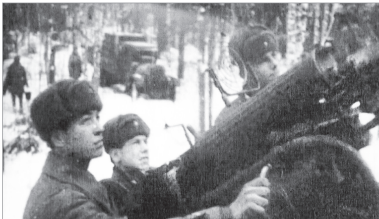
По бомбардировщику красноармейцы ведут огонь из зенитной четырехствольной установки М-4 (четыре пулемёта «Максим» образца 1931 года).
