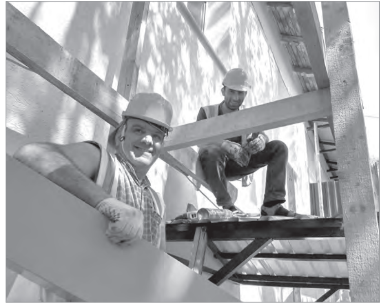
Ул. Никитина, 70а. Ремонт утепленного фасада завершен.
