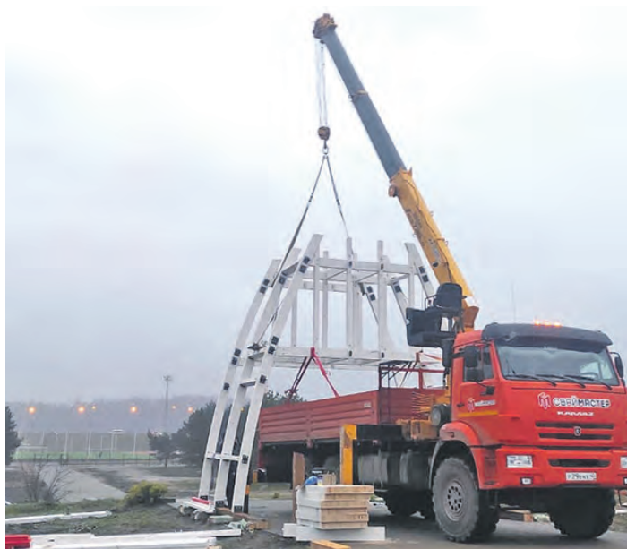
Монтаж конструкции – строго по технологии.
