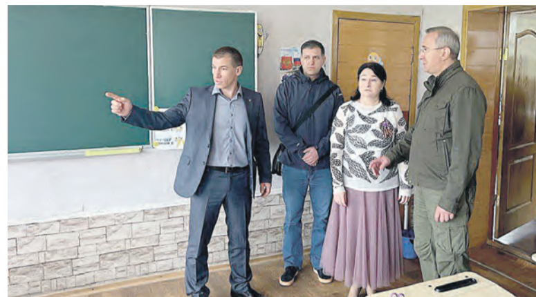
В школе № 16 г. Золотое полным ходом идут ремонтные работы.
