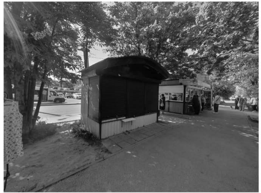
Торговый павильон по адресу: г. Калуга, ул. Вишневого, у д. 2.
