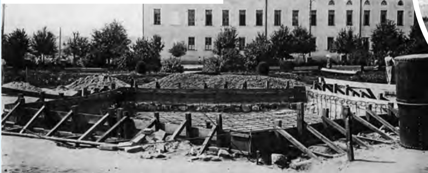
Строительство в 1935 году. Фото из архива КОМЗ.
