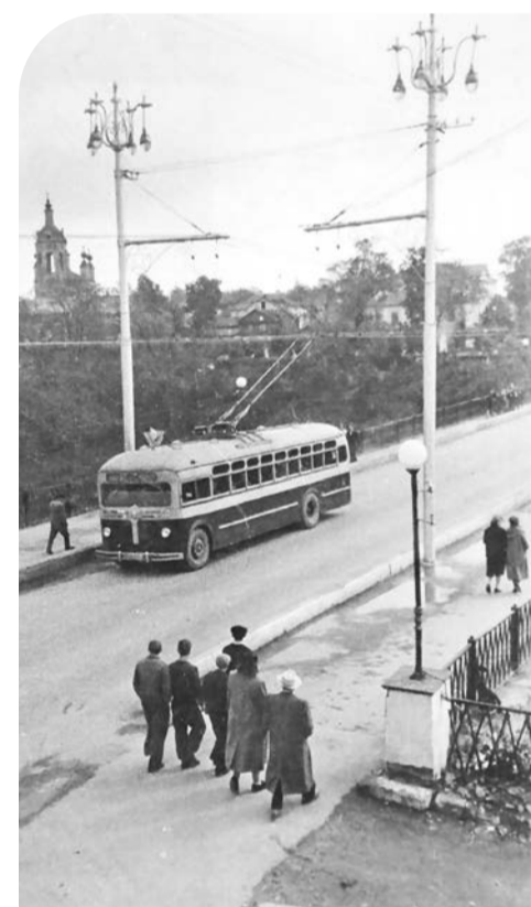
Троллейбус движется по маршруту № 1, который после 10 сентября 1957 года продлили до парка им. Циолковского. При этом арки Присутственных мест подверглись реконструкции. Интересны на фото опоры для контактной сети, изготовленные на «Машзаводе», с пятиконечными звездами и оригинальными фонарями.
