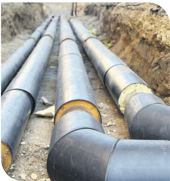
Градоначальник Дмитрий Денисов проверил ход работ по замене тепловых сетей на улице Пролетарской.
